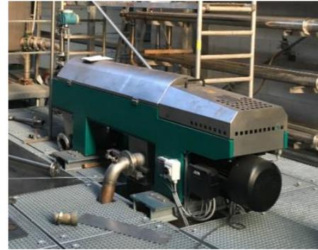
Figura 4 – Centrífuga *decanter*
